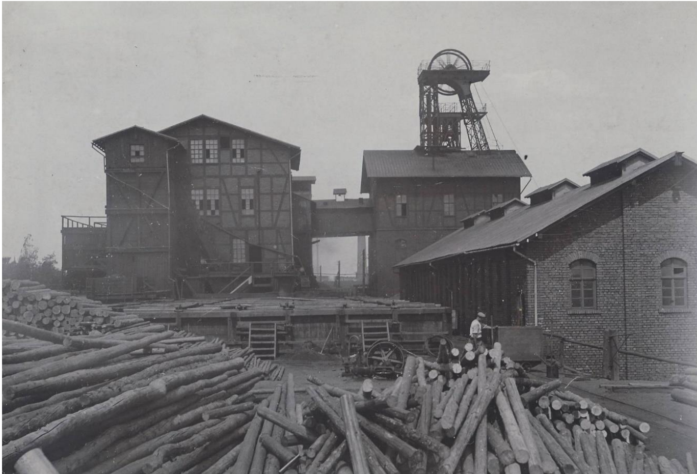
Ida-Schacht oder Rosa-Luxemburg-Schacht in Hohndorf
